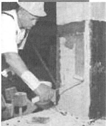
Applying a coat of Mapewrap Primer 1
